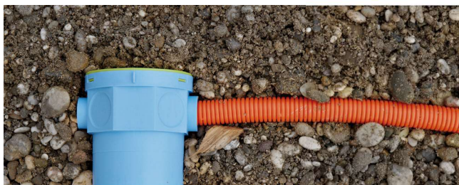
Ugradnja razvodne kutije PBN8080
